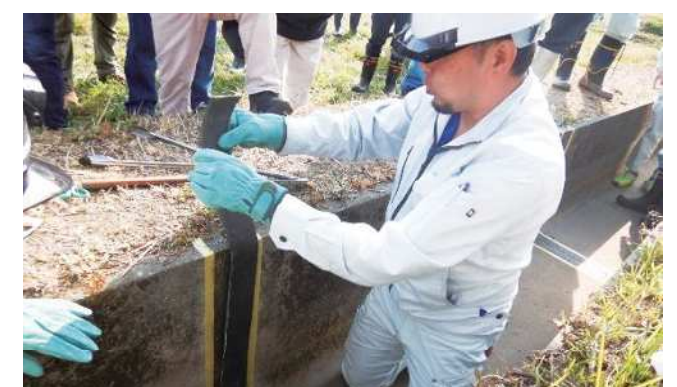
テープタイプの施工状況
