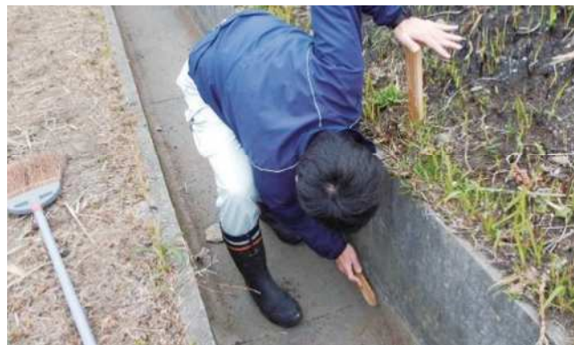
水路の清掃の状況
