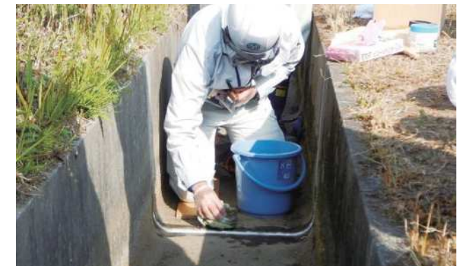
水中パテを目地に接着している状況
