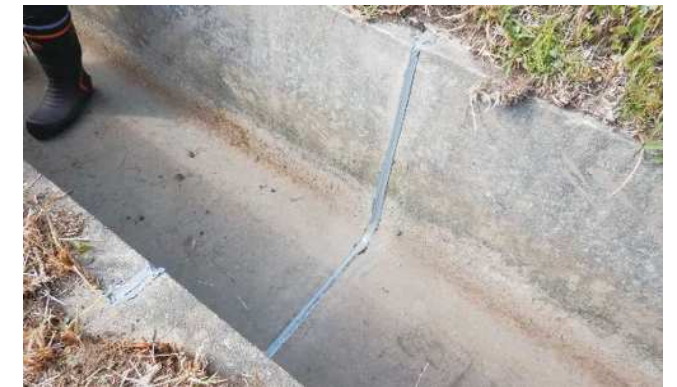
シーリング工法完了時
