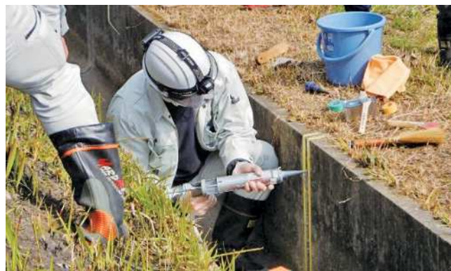
シーリング材注入の状況
