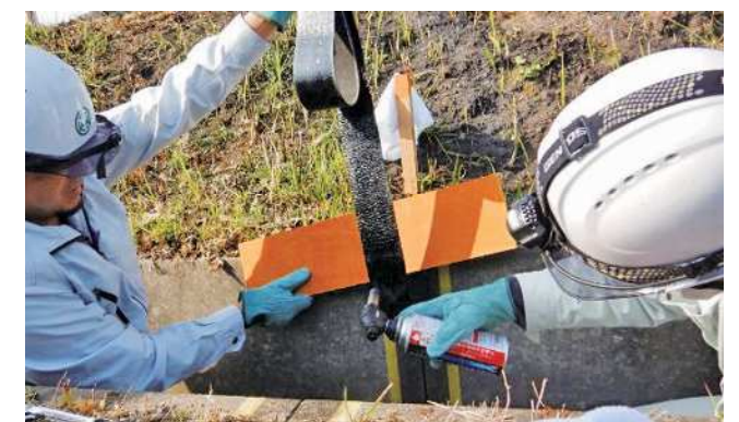
シートをあぶっている状況
